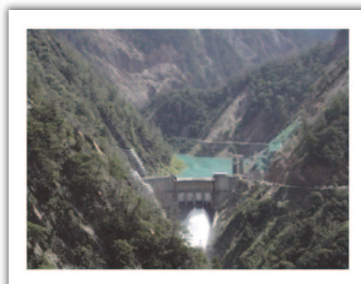
圖五 明潭抽蓄水力發電廠
