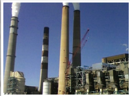
圖二十 (1) 發電機相片；(2) 火力發電廠相片。 ( http://en.wikipedia.org/wiki/Fossil_fuel_power_plant )
